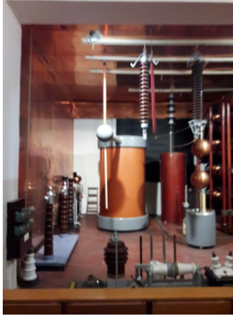
Blick auf den ölgefüllten Transformator mit Primär- und Sekundärwicklung
